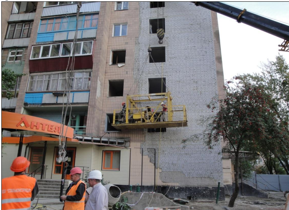
Abb. 2. Die Mörtelpumpe im Betrieb auf der Baustelle in der Stadt Charkow
