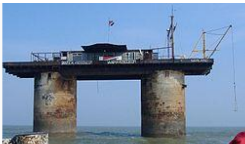
Силенд после пожара
